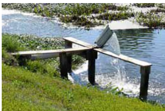
Salida alimentado por gravedad. Ángulo de tubo se puede ajustar para alterar el caudal y la profundidad de la piscina.
