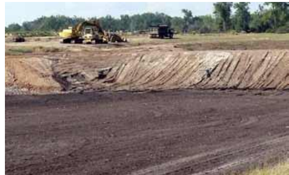
Los suelos en el dique y la parte inferior de las células deben tener un tamaño de partícula pequeño y compacto de fácil restringir la penetración del agua
