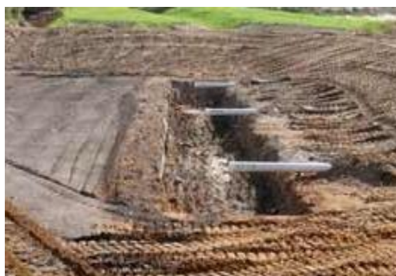
Tubo de salida de agua para alimentar por gravedad el agua de una célula a la siguiente.
