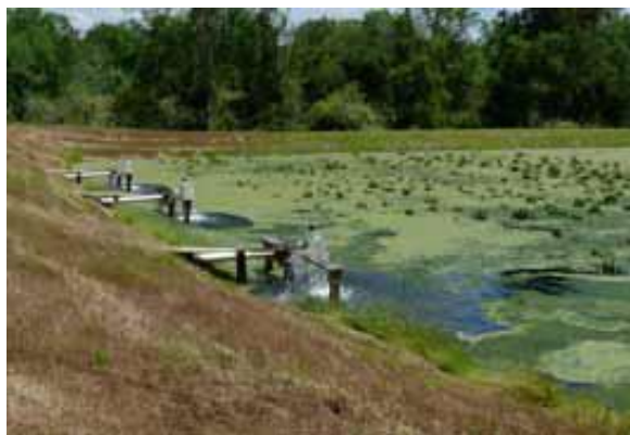
Entradas dirigen agua hacia las células de los humedales.
